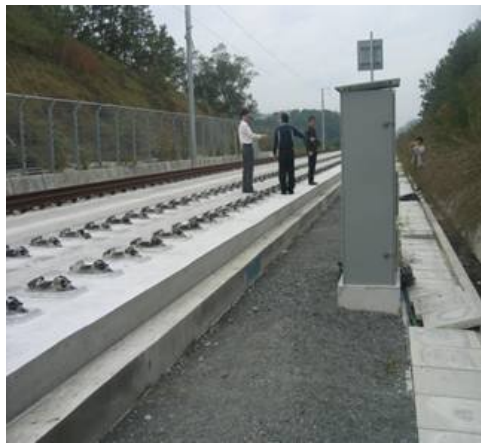
Figure 9: Voie sur dalle en Corée (Rehda 2000)
